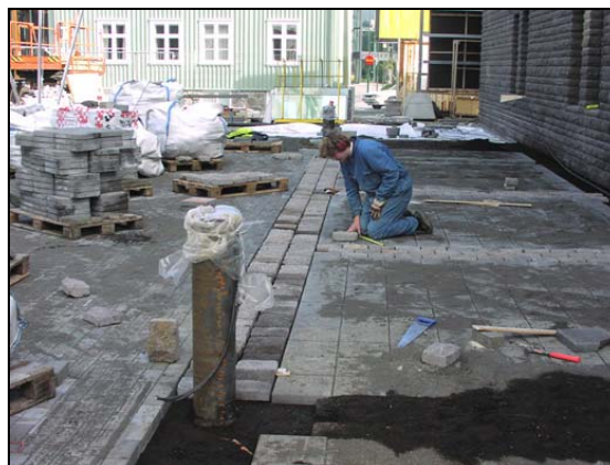
Unnið við hellulögn vestan við þjónustuskála.
