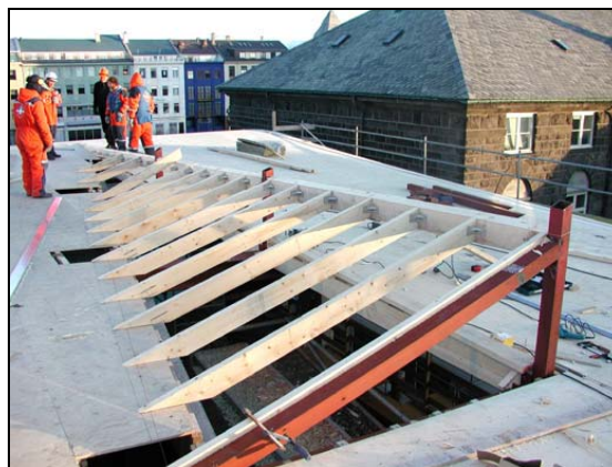
Unnið við þakglugga.
