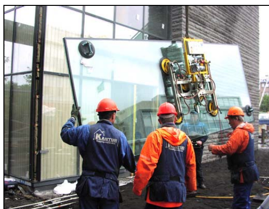
Unnið við glerjun.
