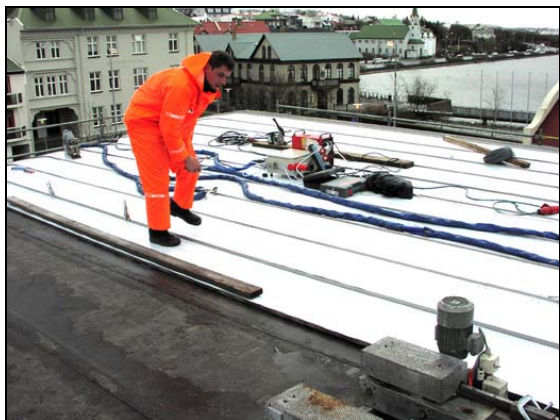
Unnið við frágang á þaki.
